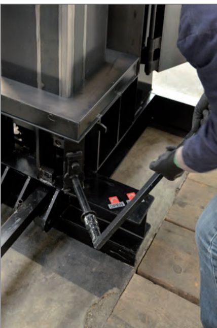
Öffnen der Exzentrerspindel mit Steckschlüssel
