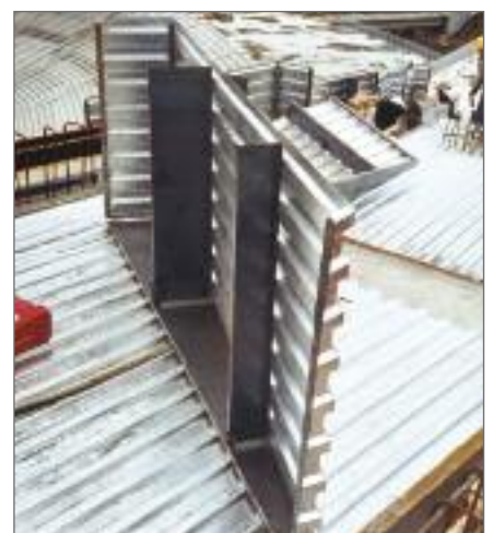
Sonder-Aussparungskästen zur Herstellung von Hohlkörperdecken, speziell angepasste Varianten an unterschiedliche Deckenneigungen
