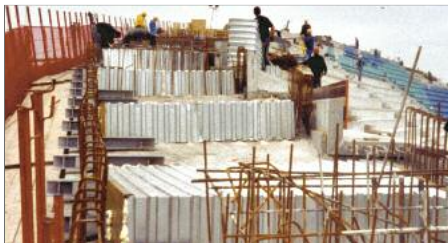
Sonder-Aussparungskästen zur Herstellung von Hohlkörperdecken, speziell angepasste Varianten an unterschiedliche Deckenneigungen
